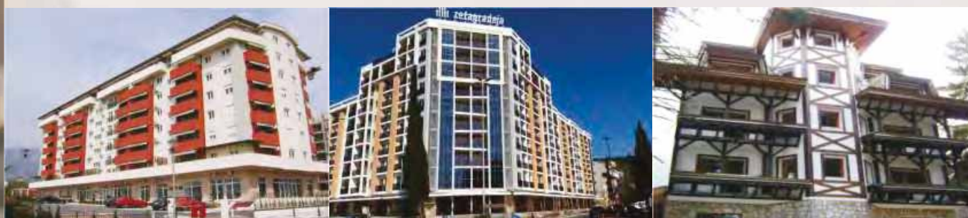
stambena zgrada - Bar
